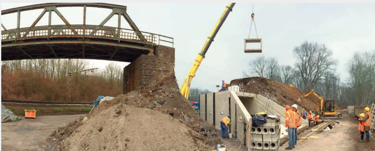
Der Einsatz von Fertigteilen erspart dem Bauunternehmer einen aufwändigen Verbau, das Anlegen von Hilfsbrücken und den Einsatz von Ortbeton. (Bild: DB Netz AG)
