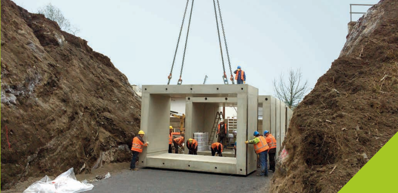
Ein 500-Tonnen Mobilkran brachte die 14 Fertigteile mit einem Gewicht von bis zu 34 Tonnen an Ort und Stelle. (Bild: DB Netz AG)
