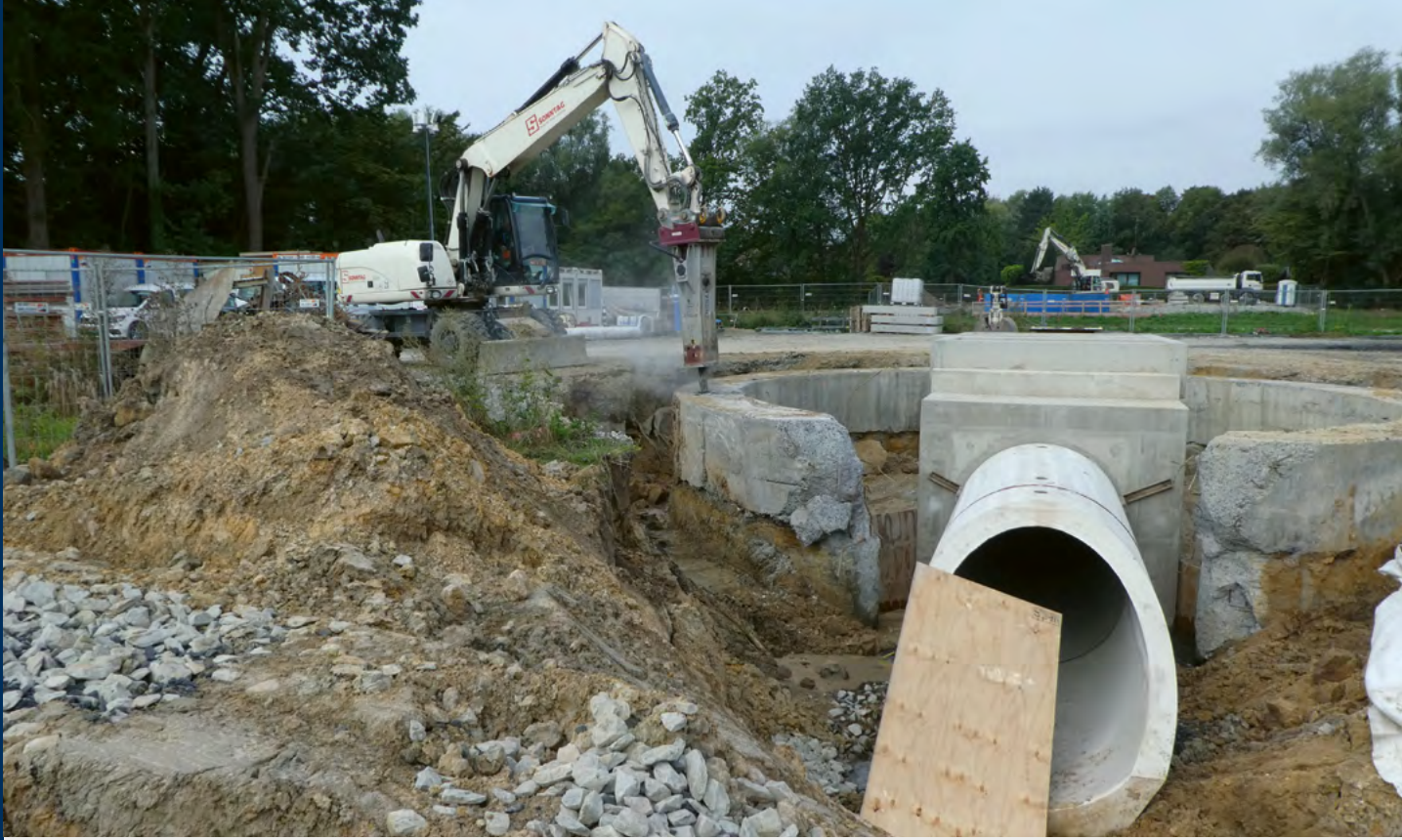
Anschlußgelenk am Auslaufbauerk. (Bild: Wasserstraßen- und Schifffahrtsamt Rheine)
