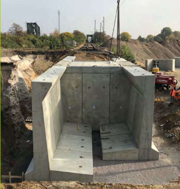
Maßarbeit: Alle Stahlbetonfertigteile passen perfekt zusammen. (Bild: Bauunternehmung Hofschröder GmbH & Co. KG)
