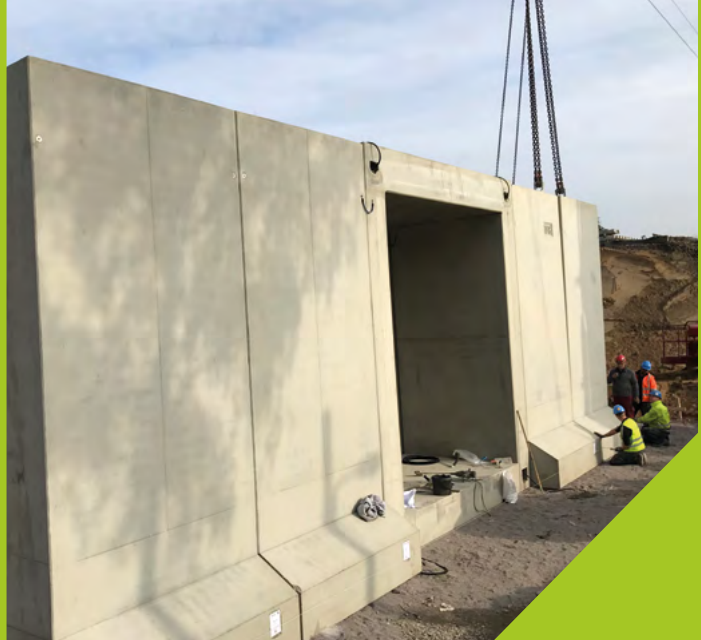
Im Vergleich zur Ort betonbauweise konnte eine Sperrpause eingespart werden. (Bild: Bauunternehmung Hofschröder GmbH & Co. KG)
