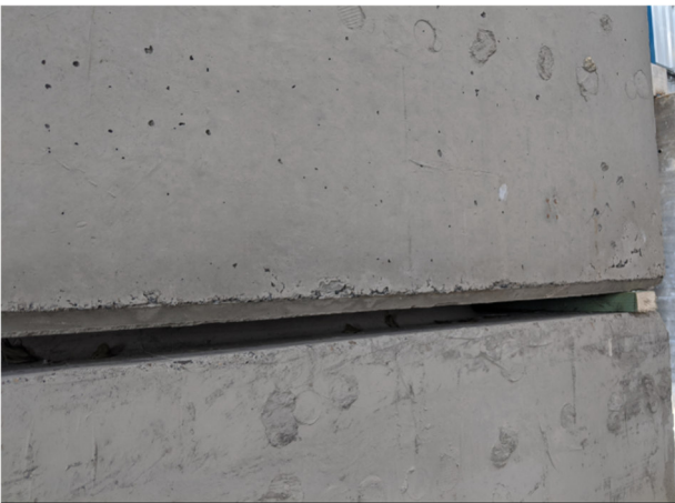
Verbindung Außen mit Distanzholz
