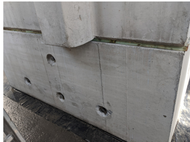
Detail Abdichtung gegen den Untergrund
