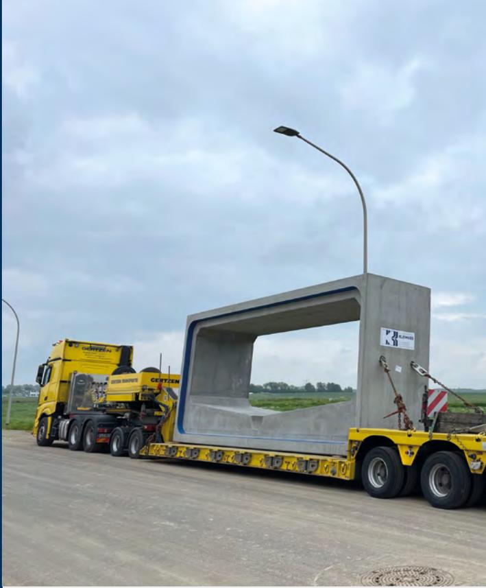
Schwerarbeit: Bis zu 50 Tonnen wiegen die einzelnen Elemente für de Stauraumkanal.
